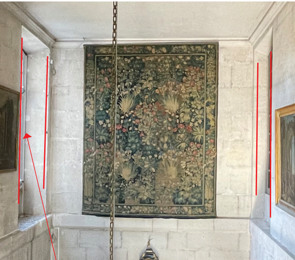
Eloignement du rail du châssis de fenêtre car il s'agit d'une fenêtre de désenfumage
